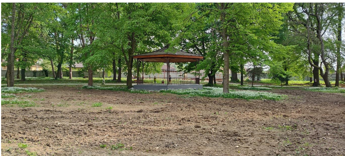
Dominanta parku č. 2 – rekonštruovaný altánok nová drevená strecha, oceľ. konštrukcia, dlažba, náter
